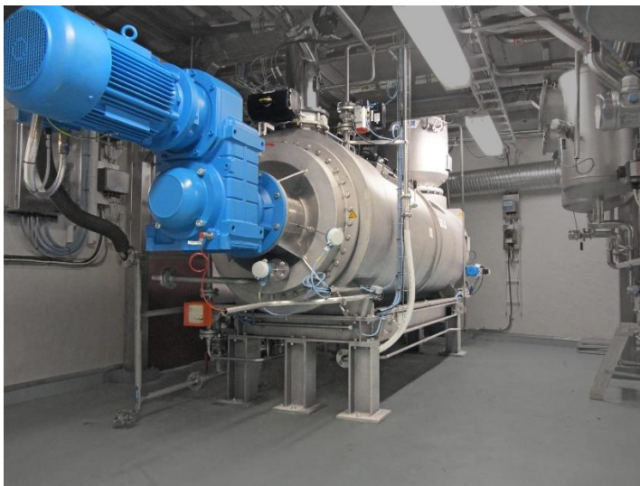
Figuur 2: Voorbeeld van BHS continue contactdroger
